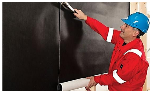
Vindspærre af kunststoffypen. Foto: Tyvek
