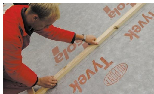
Undertag af diffusionsåben banevare.
