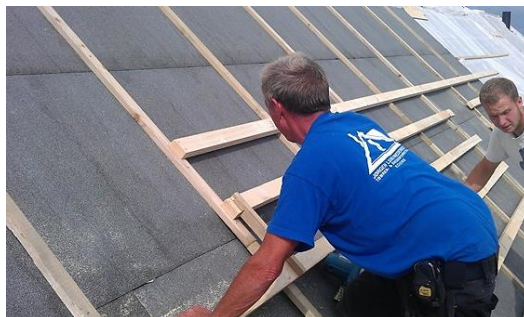
Fast undertag på tagbrædder.
