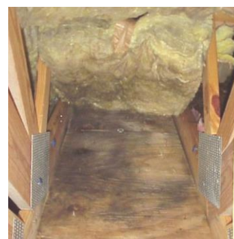
Eksempel på loftrum der er isoleret med våd isolering. Der er kraftig vækst af skimmelsvamp. Ventilationen i loftrum er IKKE tilstrækkelig til udtørring af isoleringsmaterialet.
