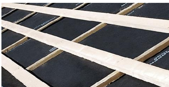
Undertag af diffusionsåben banevare.
